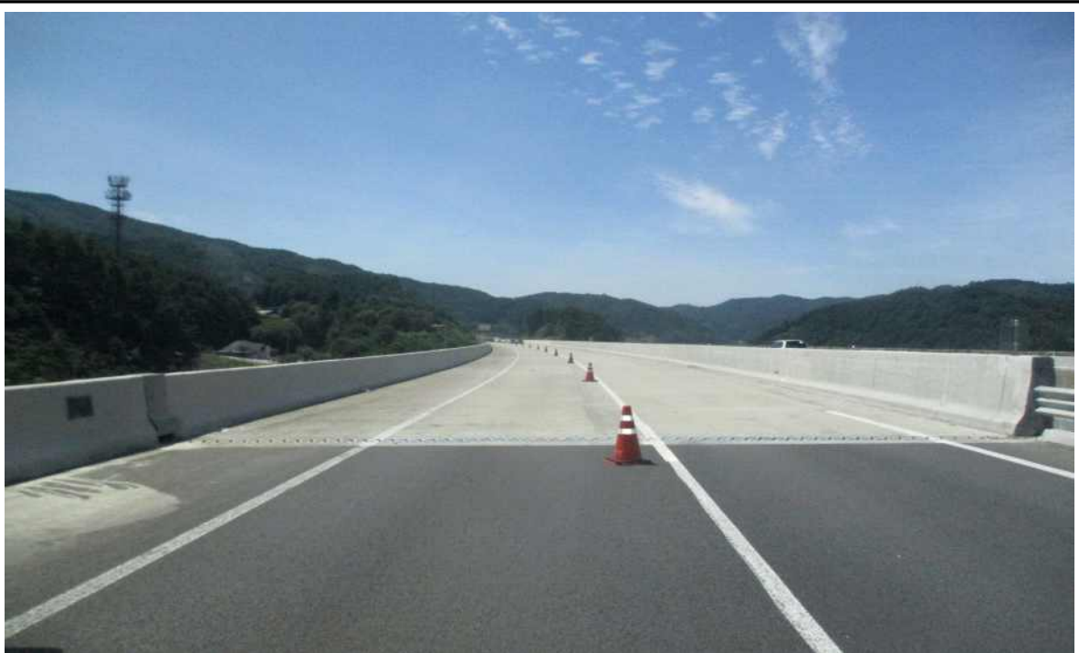
교량 상부 전경
